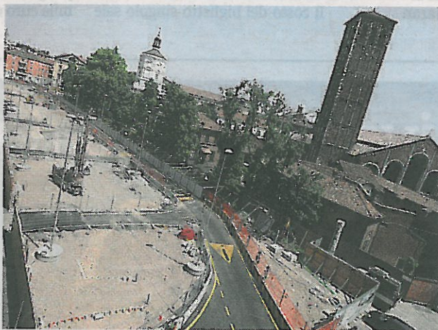
Sottoterra Il cantiere per i box auto a Sant'Ambrogio
